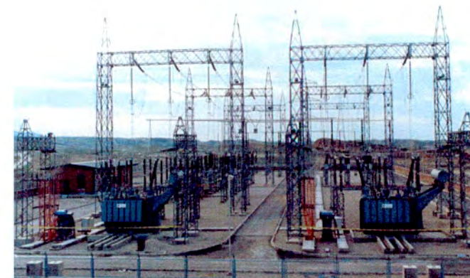
ترانسفورماتورهای قدرت و کمپکت کمکی و زمین پست برق بینک
