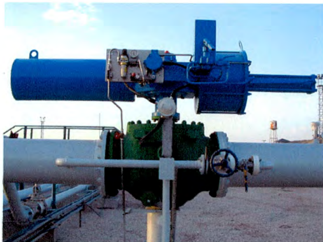
شیر ON/OFF گاز ورودی از محوطه BPUCF
