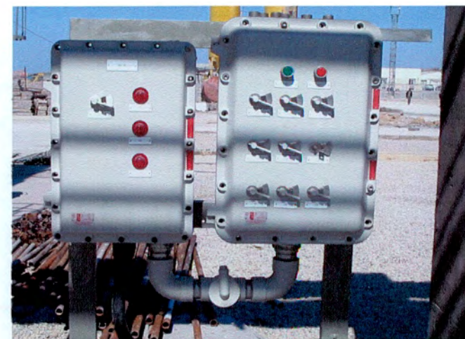
تابلو روشنایی ضد انفجار پایپرک
