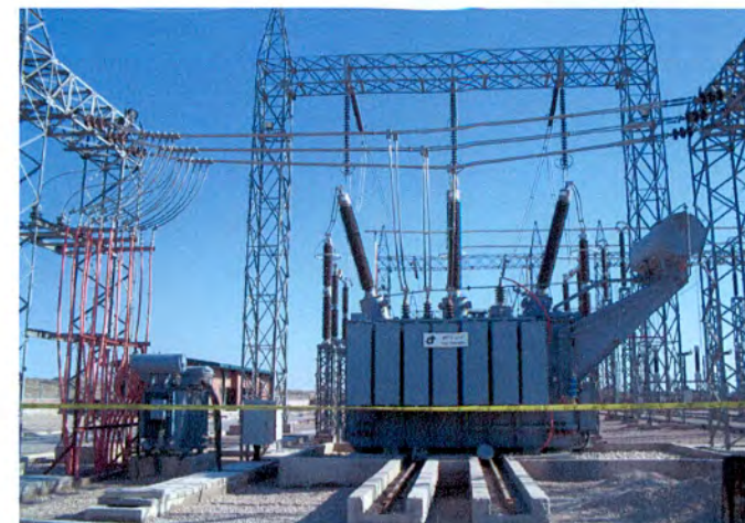
ترانسفورماتورهای قدرت و کمپکت کمکی و زمین پست برق بینک
