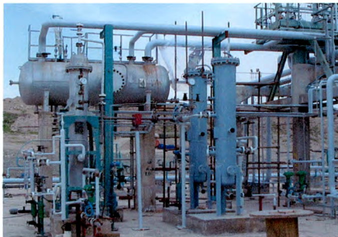
فیلترهای گاز F-4601A/B و مخازن تحت فشار V-1002, V-4601
