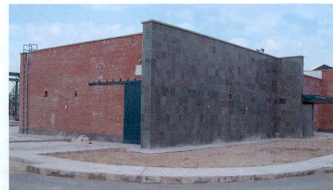
نمای جنوب غربی ساختمان ضد انفجار ساختمان کنترل
