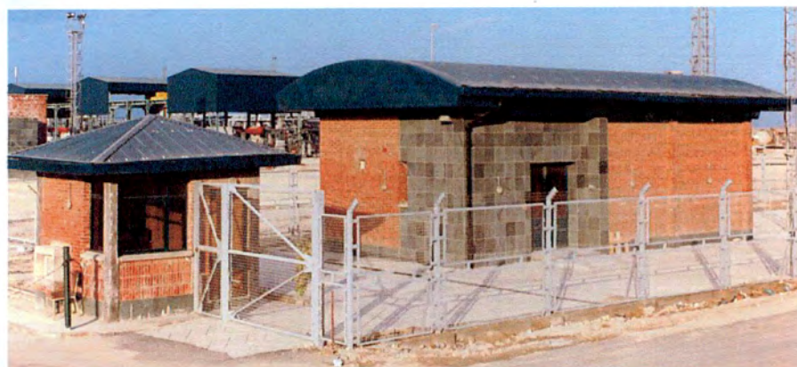
نمای جنوب شرقی ساختمان و پست نگهبانی مخابرات
