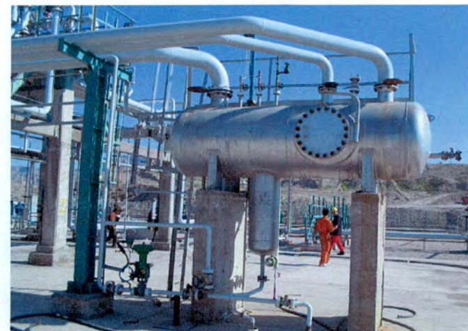
مخزن تحت فشار V-1003
