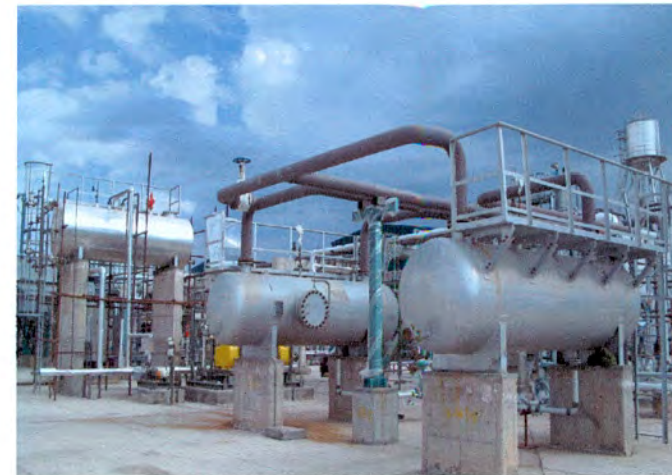
مخازن تحت فشار V-4003,4 و مخزن ذخیره گلایکل TK-4901
