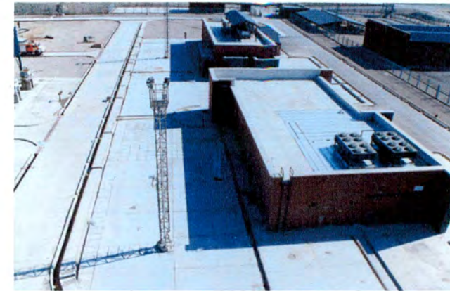
محوطه ساختمانهای کنترل و سوئیچگیر
