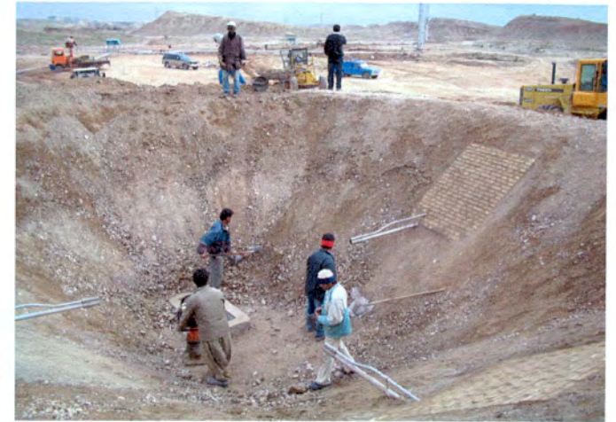
خاکریزی و کوبیدن داخل Burn Pit
