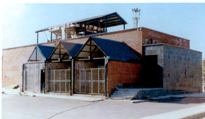
نمای جنوب شرقی ساختمان ضد انفجار سوئیچگیر
