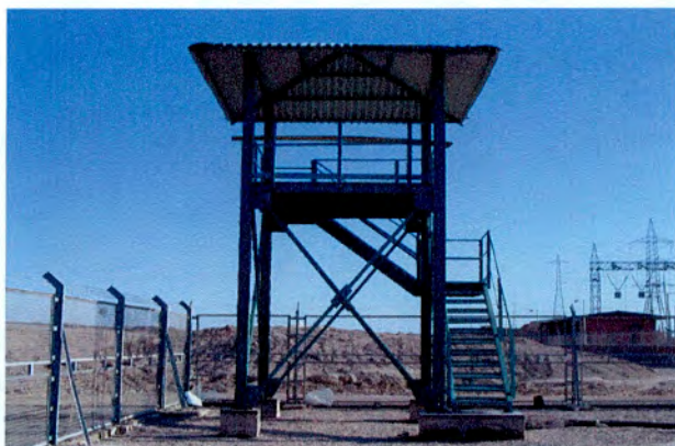
برج نگهبانی در ضلع جنوبشرقی محوطه BCS
