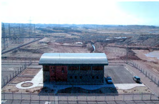
محوطه ساختمان تعمیرگاه
