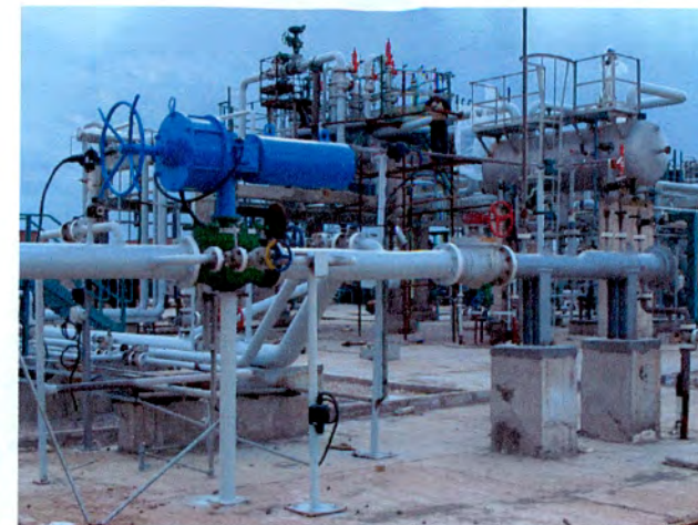
دریافت کننده توپک و شیر ON/OFF گاز ورودی از محوطه BCF
