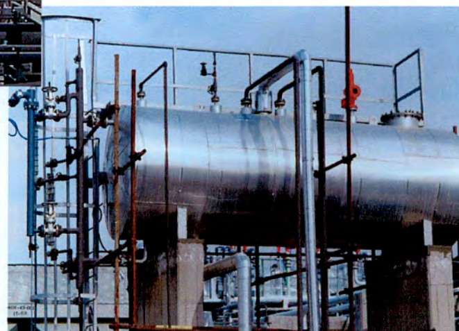
مخزن عایقکاری شده ذخیره گلاپکل
