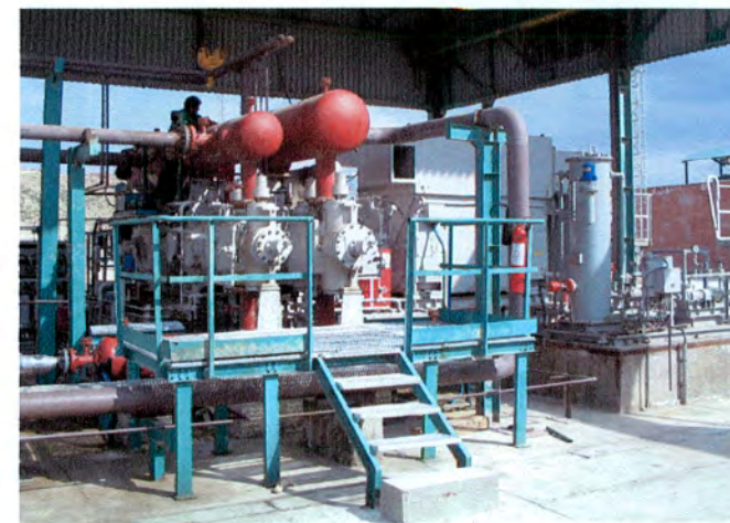
کمپرسورهای گاز C-1002,3,4A
