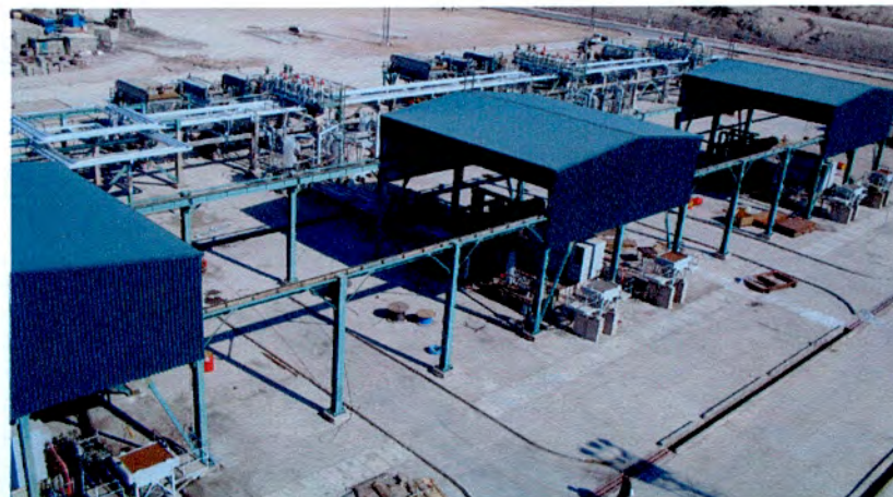
نمای جنوبی سایبان کمپرسورها
