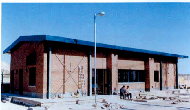
نمای شمال‌غربی ساختمان کنترل پست برق بینک
