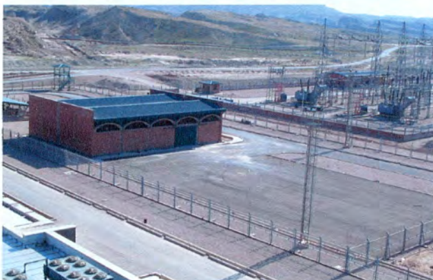
محوطه ساختمان انبار
