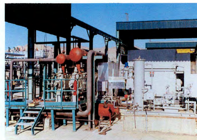
کمپرسورهای گاز C-1002,3,4C
