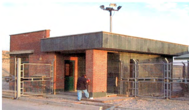
نمای شمال غربی ساختمان نگهبانی
